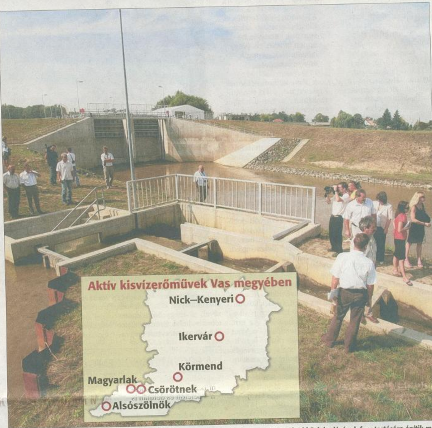
A hallépcsőt a folyóvizet teljes szélességükben elzáró duzzasztóműveknél a halak szabad közlekedésének fenntartására építik meg
