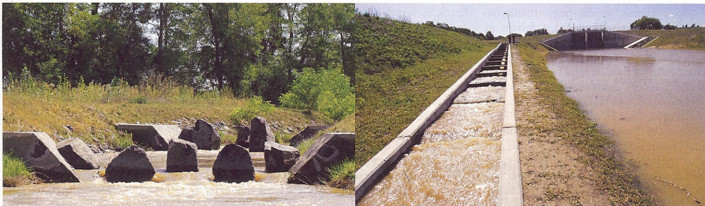
A kenyeri vízerőmű mellé épített hallépcső a folyásiránnyal szemben is szabad közlekedést biztosít a folyó élővilágának
